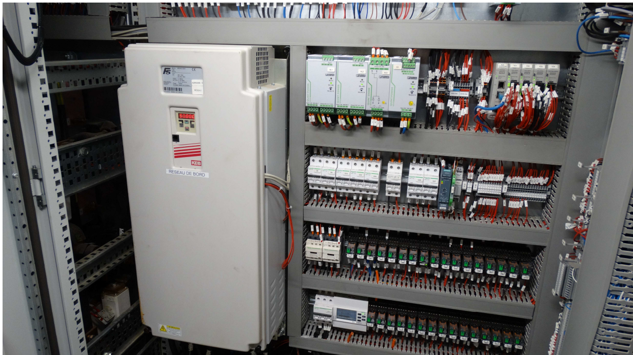
Variateur du réseau de bord
